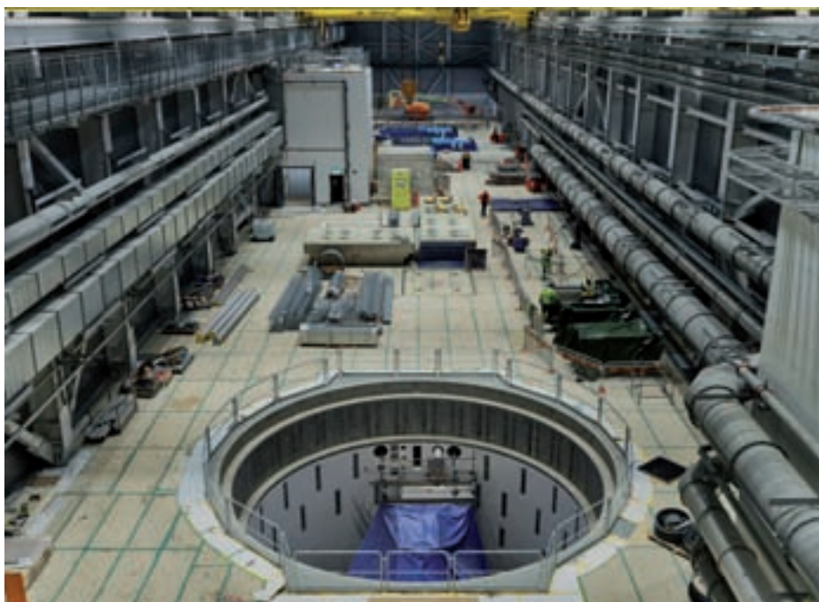
Vista general del edificio principal de la ESS.
