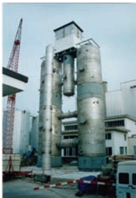
Figura 3 Instalación experimental PANDA (Fuente: PSI).
