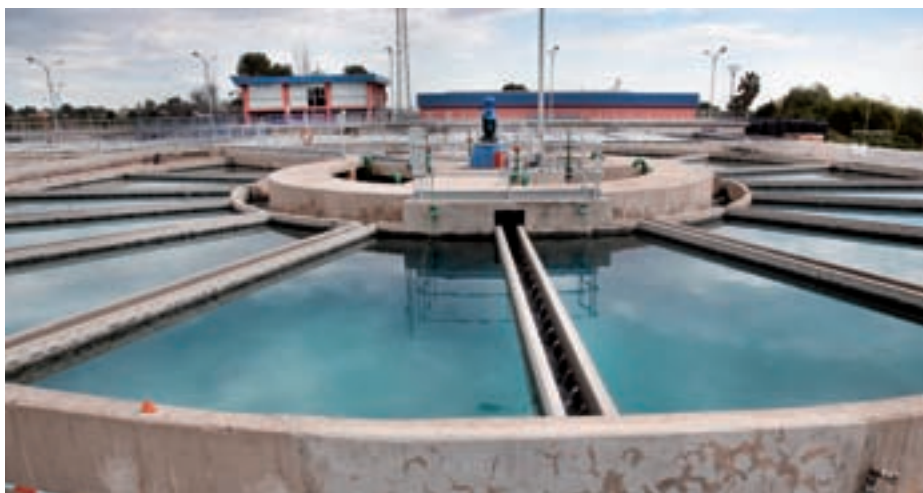
Instalaciones de tratamiento de agua en la Comunidad Valenciana.
