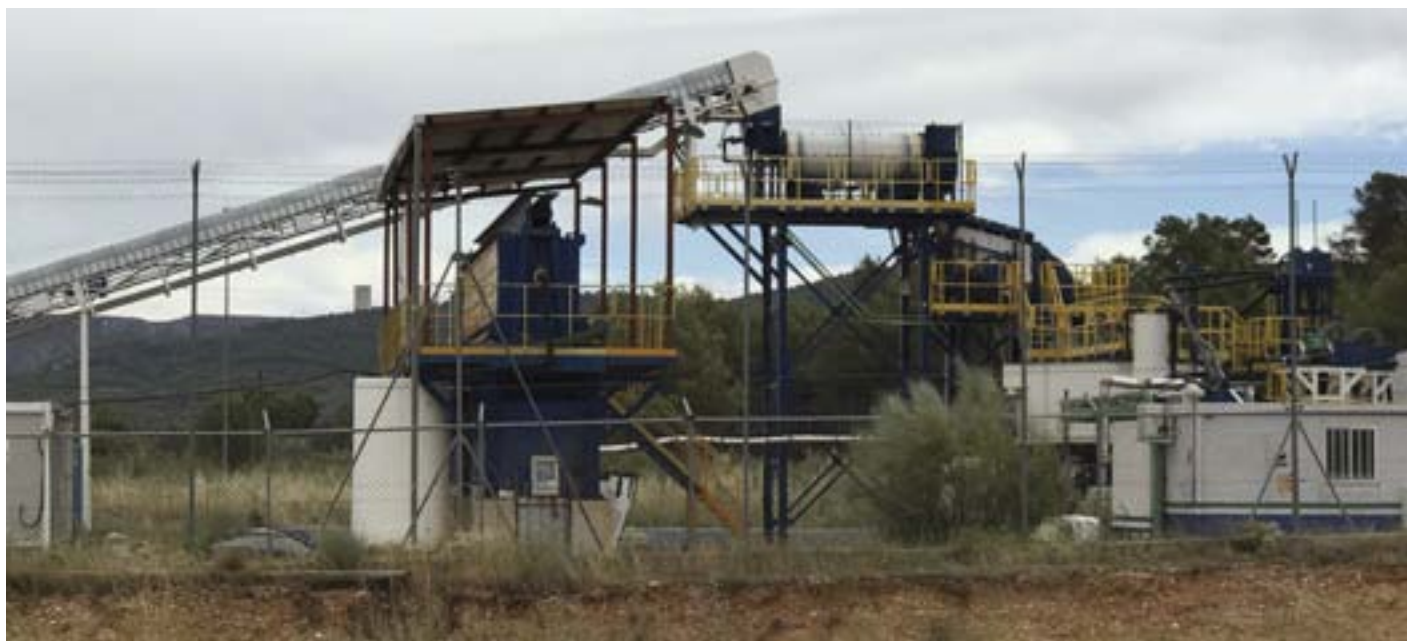
Planta de lavado de suelos del desmantelamiento de José Cabrera.
