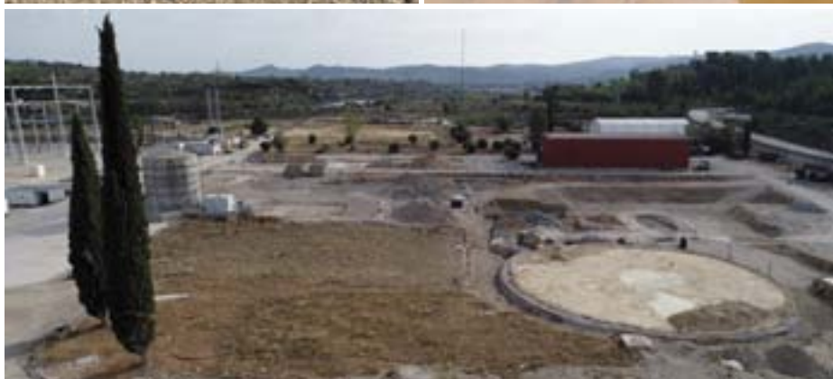
Diversas tareas realizadas durante la restauración del edificio de la contención.
