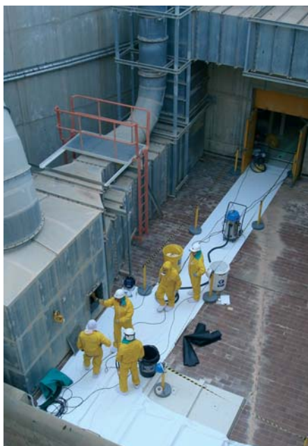
Descontaminación del plenum de ventilación.
