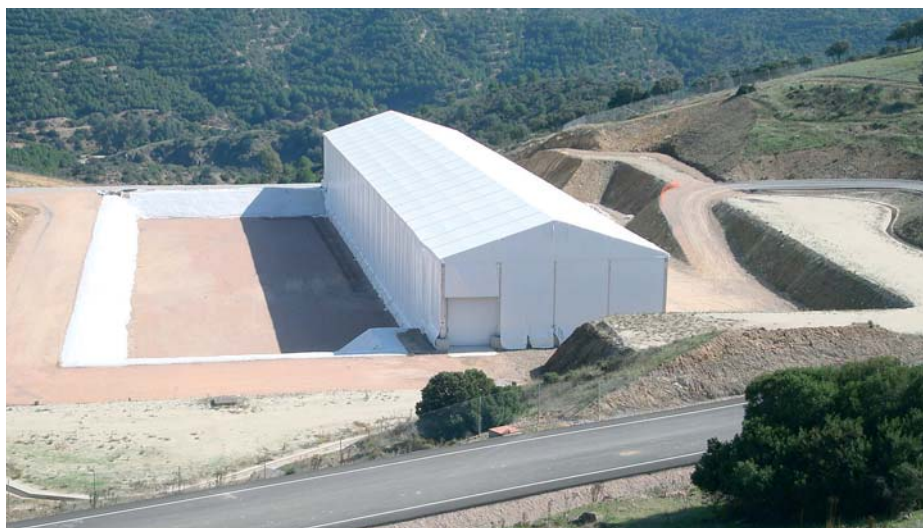
Instalación para almacenar residuos de muy baja actividad en El Cabril.
