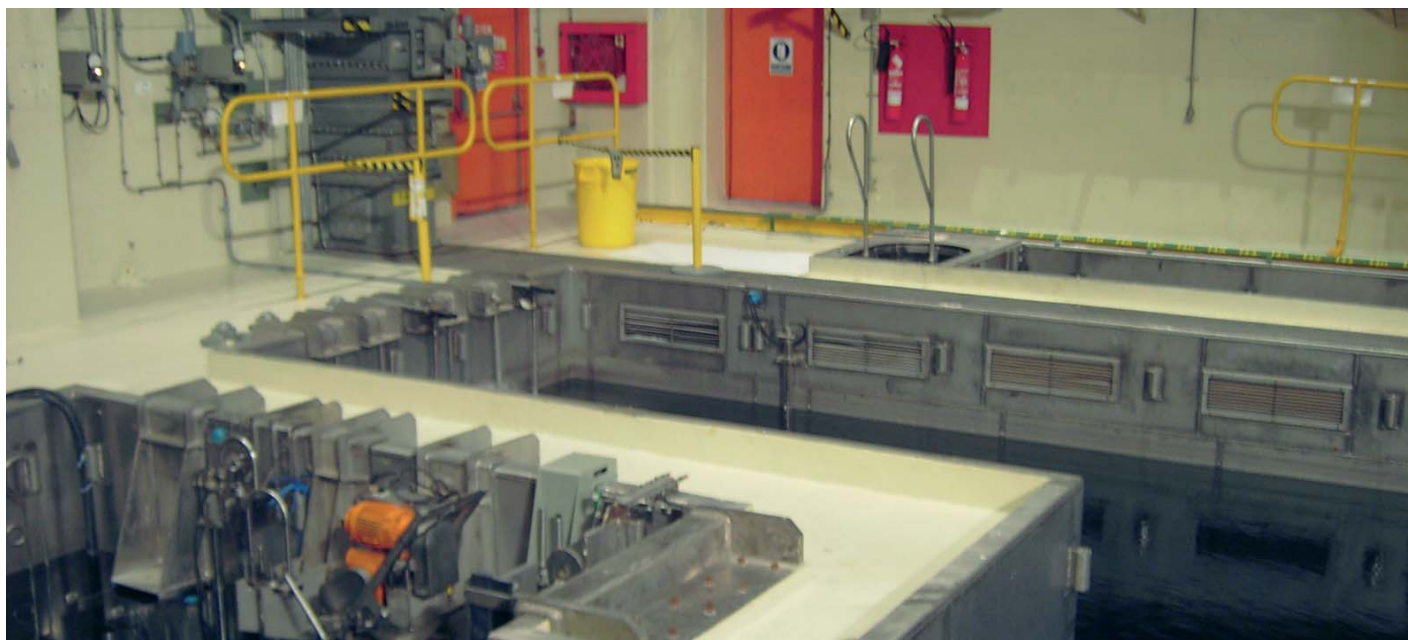
Rejillas de ventilación sobre la piscina de combustible gastado.
