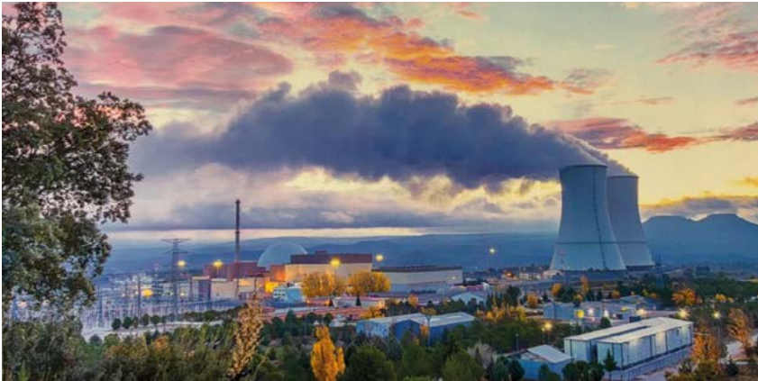
Vista panorámica de la central nuclear Trillo
