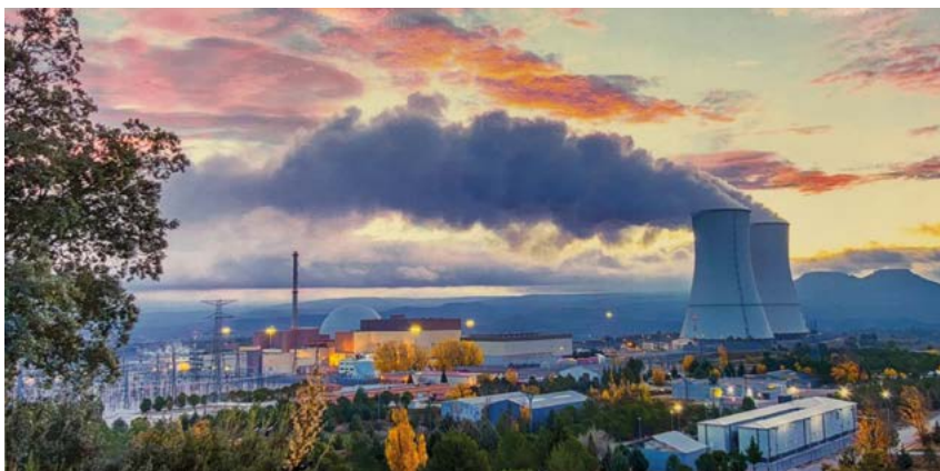
Vista panorámica de la central nuclear Trillo
