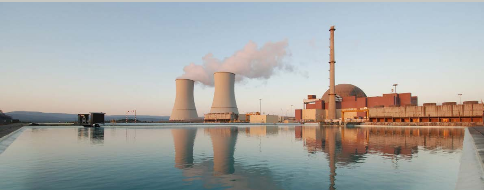
Imagen de la central nuclear Trillo
