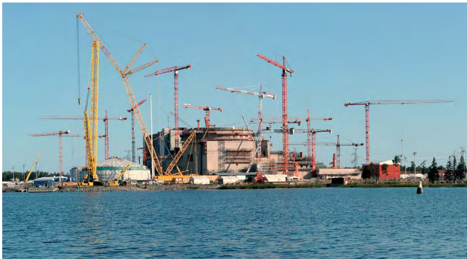
Construcción de la central nuclear de Olkiluoto 3 en Finlandia.
