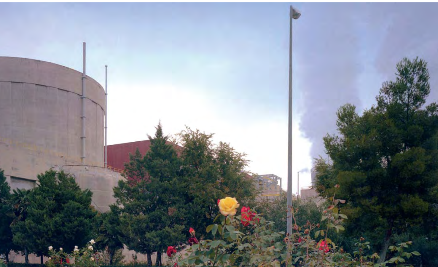
La notificación de un suceso puede dar lugar a una o varias inspecciones como ocurrió en 2008 en la central de Ascó (en la imagen).
