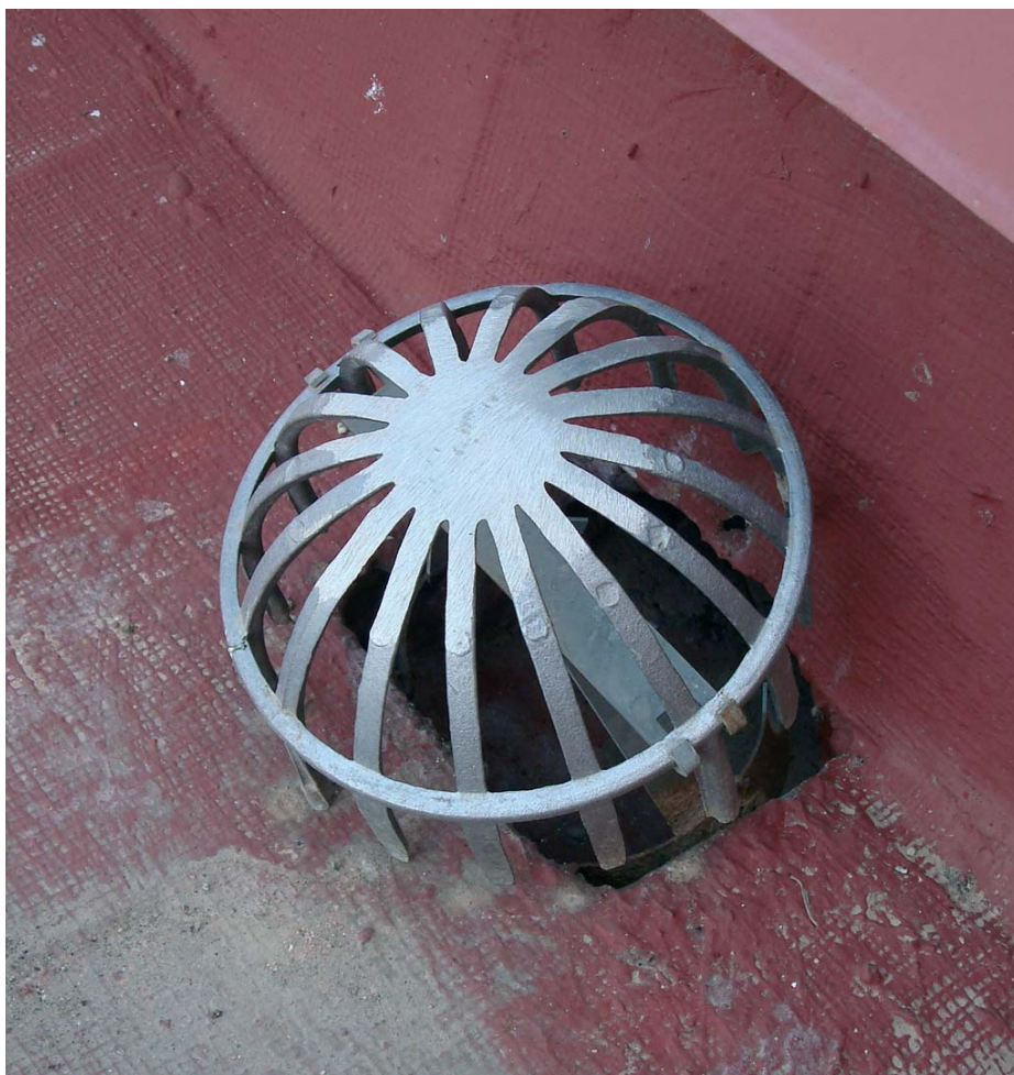
Sumidero por el que el agua de lluvia arrastró las primeras partículas detectadas.
