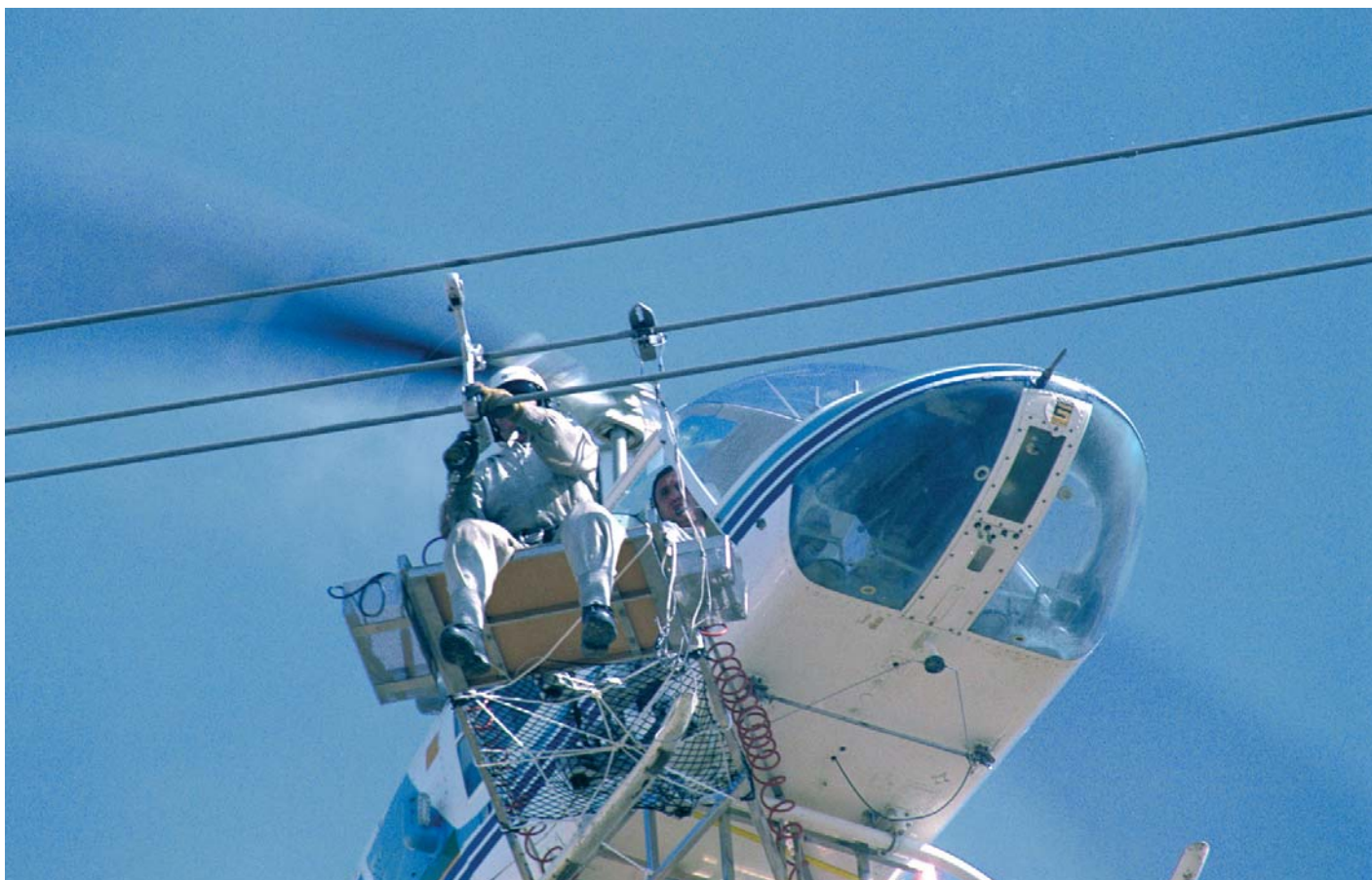
Trabajos de mantenimiento de la red. Sustitución de separadores de cables con plataforma adosada al helicóptero.
