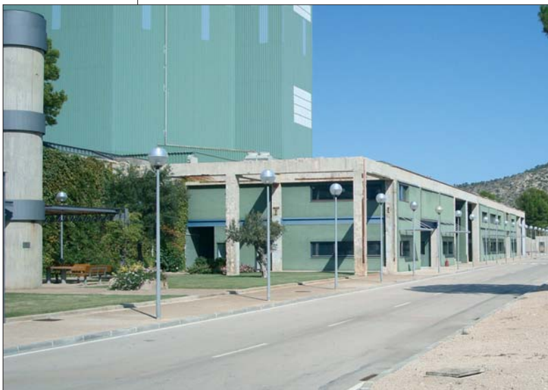
Central nuclear Vandellós I.
