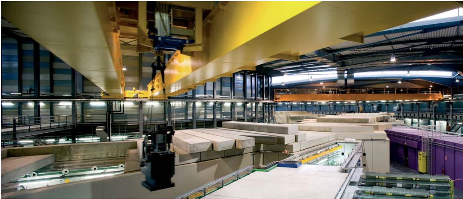
En los próximos meses se completará la puesta a punto. En la imagen, trabajos de acondicionamiento de la instalación.
