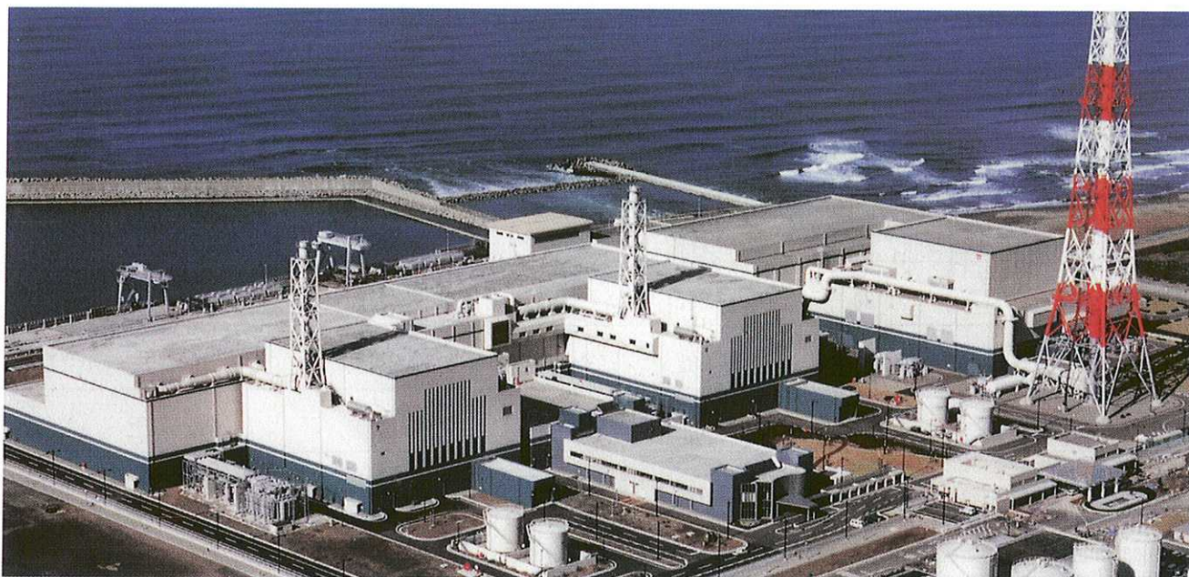
► Figura 1. Vista aérea de las unidades 5, 6 y 7 de la central nuclear de Kashiwazaki-Kariwa (Japón). Las dos últimas (centro e izquierda de la imagen) son centrales ABWR.
