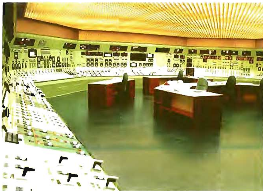
Figura 4. Simulador de entrenamiento PWR (Tecnatom).
