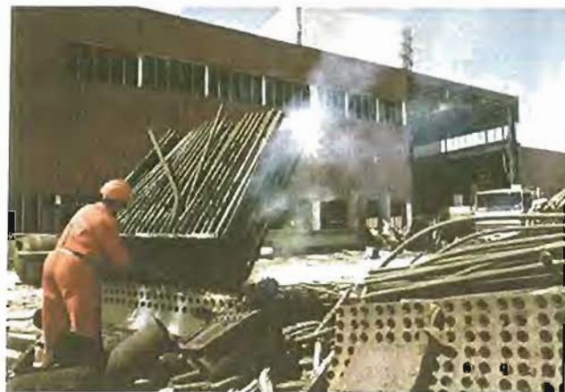
El nuevo reglamento regula la clausura de instalaciones nucleares. En la imagen, trabajos de desmantelamiento de Vandellós I.
