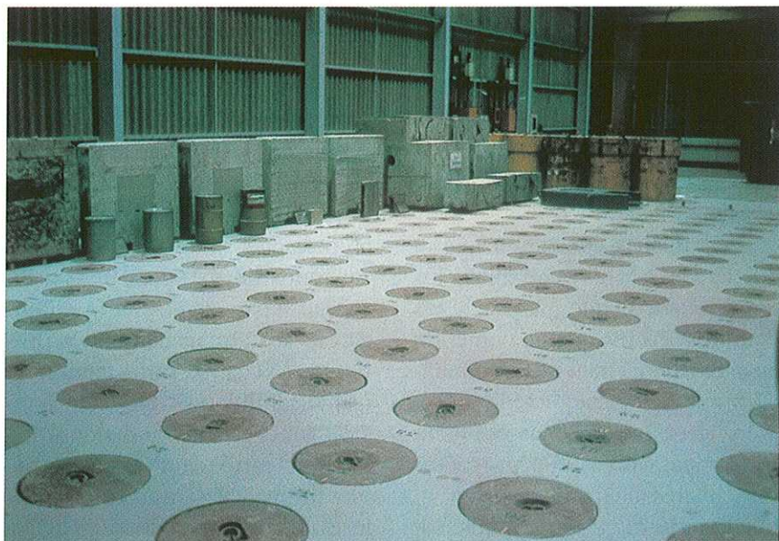
► Figura 3. Almacenamiento de residuos de alta vitrificados en Marcoule (Francia).
