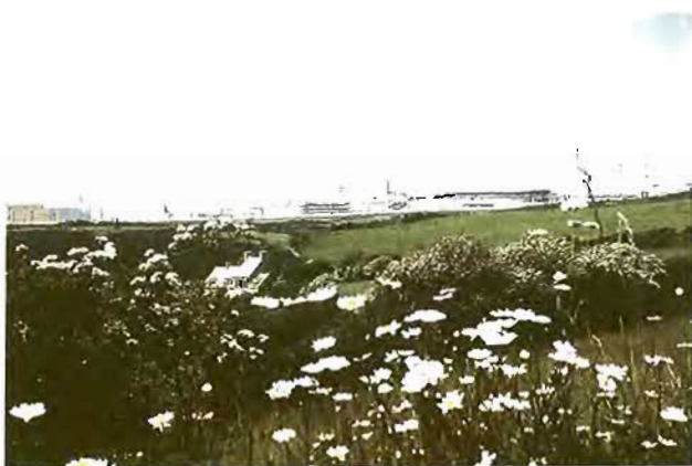
Instalación de tratamiento de Cogema en La Hague (Francia).
