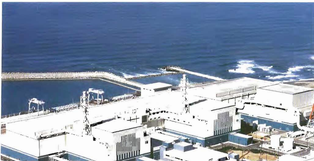
► Figura 1. Vista aérea de las unidades 5, 6 y 7 de la central nuclear de Kashiwazaki-Kariwa (Japón). Las dos últimas (centro e izquierda de la imagen) son centrales avanzadas del tipo ABWR, de tecnología General Electric.
