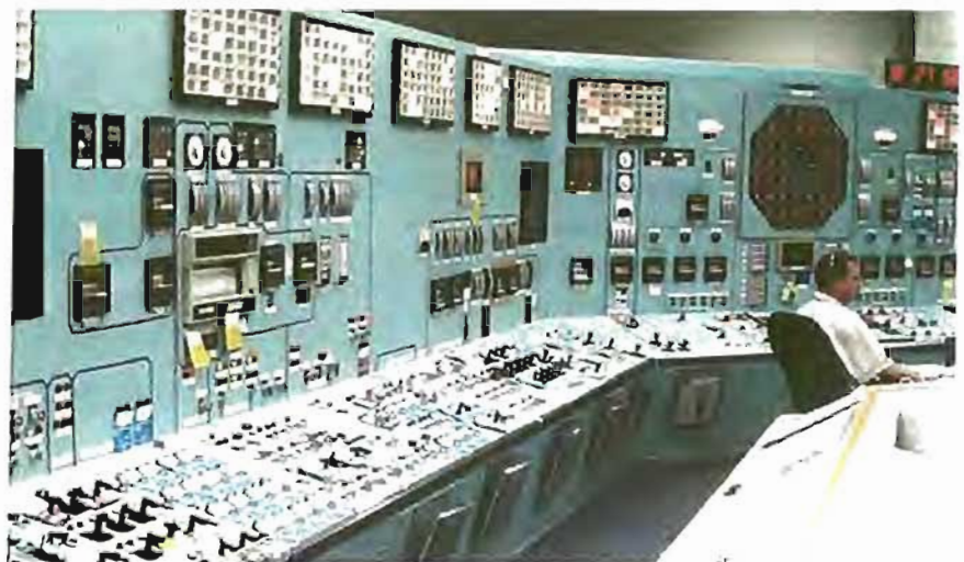
● Figura 9. Aunque el Centro de Hanford se encuentra en fase de desmantelamiento, los responsables han tenido el buen gusto de conservar el reactor B como un monumento histórico americano. Aquí se muestra la sala de control del reactor, muy simple como se observa a simple vista, a pesar de que en su época última el reactor trabajaba a 1.950 MWt.
