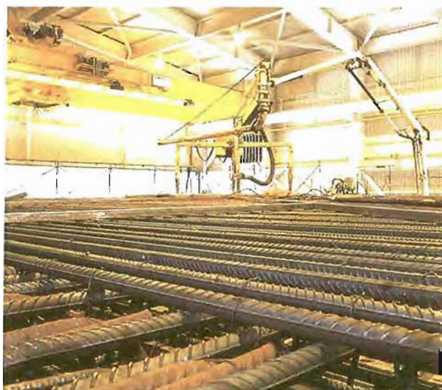
Plataforma de almacenamiento del centro de El Cabril.
