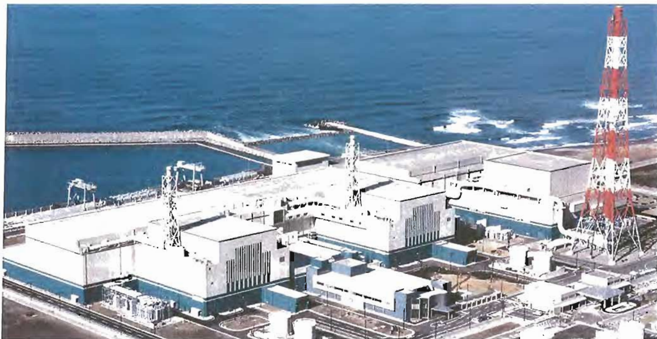
► Figura 3. Vista aérea de las unidades 5, 6 y 7 de la central nuclear de Kashiwazaki-Kariwa (Japón). Las dos últimas (centro e izquierda de la imagen) son centrales avanzadas del tipo ABWR, de tecnología General Electric.
