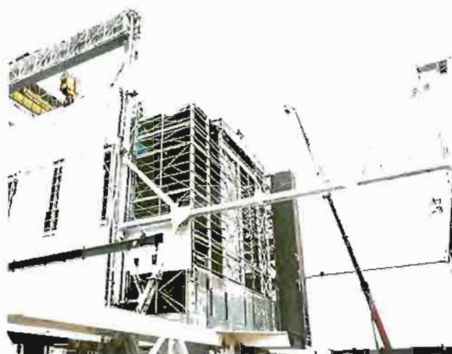
Desmontaje de la central nuclear Vandellós I.
