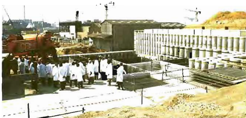
► Figura 3. Visita al centro de almacenamiento de residuos radiactivos de La Manche (Francia).
