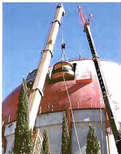
Operaciones de cambio de la tapa de la vasija en José Cabrera.
