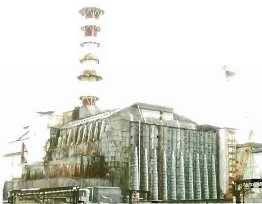
► Figura 2. Vista de la central nuclear de Chernóbil.
