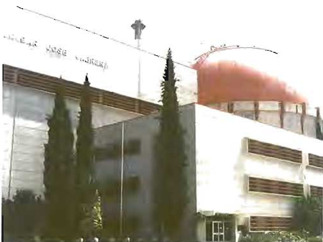
Fachada de la central nuclear José Cabrera.
