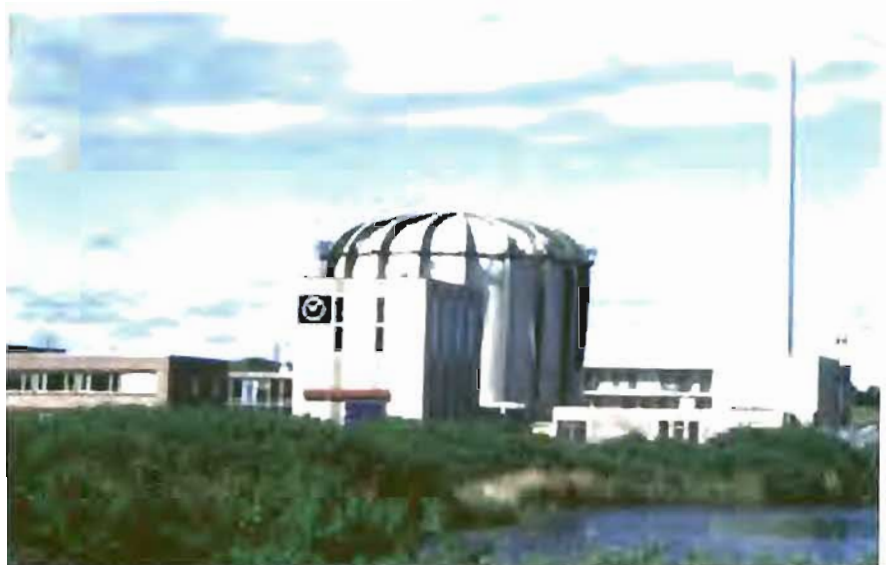
Figura 9. Reactor nuclear de Petten (UE).
