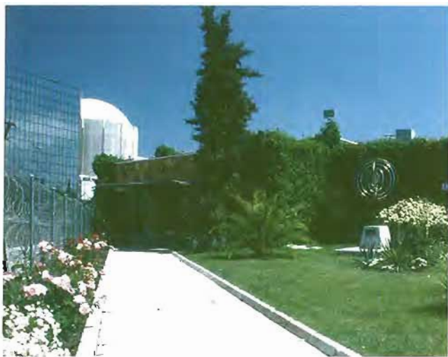
Vista de la central nuclear de Almaraz.
