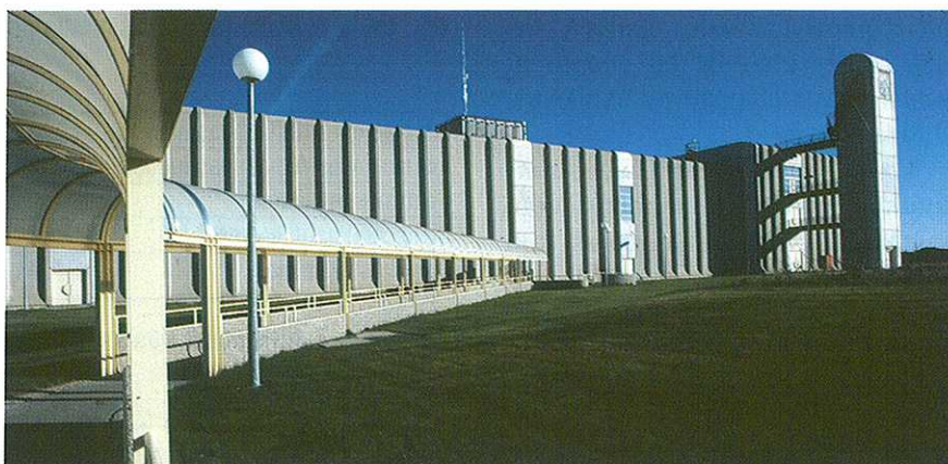
► Figura 1. Vista exterior de la fábrica de combustible de Juzbado (Salamanca).
