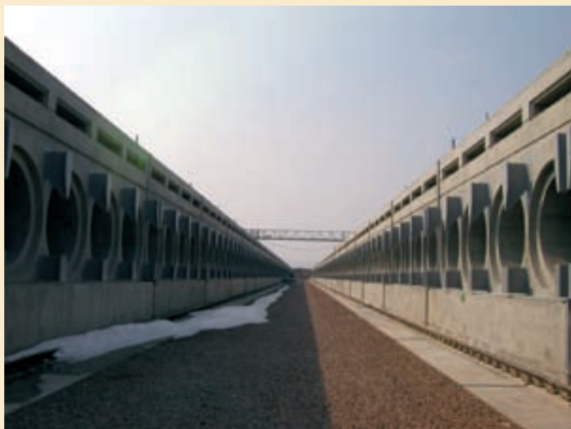
Almacenamiento de combustible.
