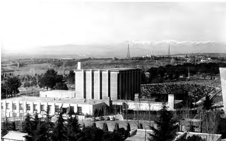
► Figura 2. Edificio del reactor JEN I.
