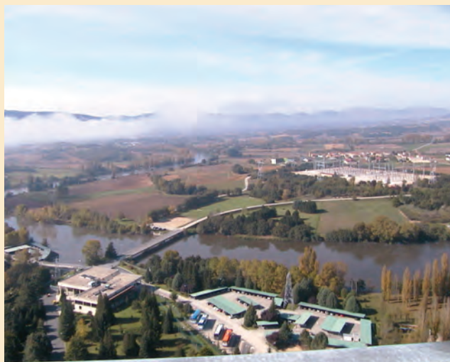
Vista panorámica, con el parque eléctrico al fondo, de la central nuclear Santa María de Garoña.
