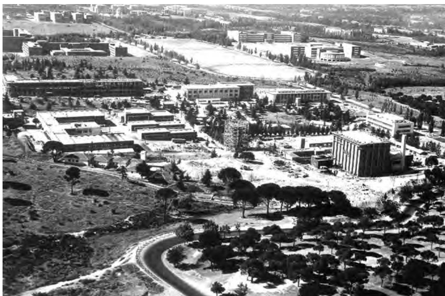
► Figura 1. Vista aérea de la Junta de Energía Nuclear (JEN) en la Ciudad Universitaria de Madrid, en 1970.
