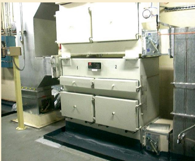
Filtro secundario de efluentes radiactivos gaseosos de la fábrica de combustible de Juzbado.
