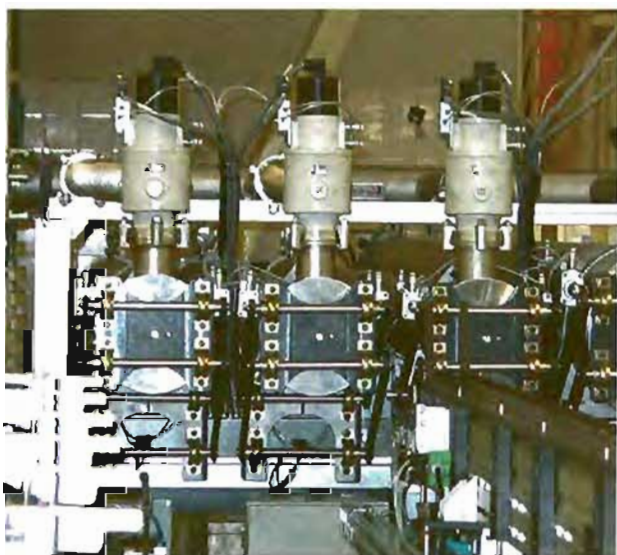
Sistema de manejo de detección de fugas de Juzbado.
