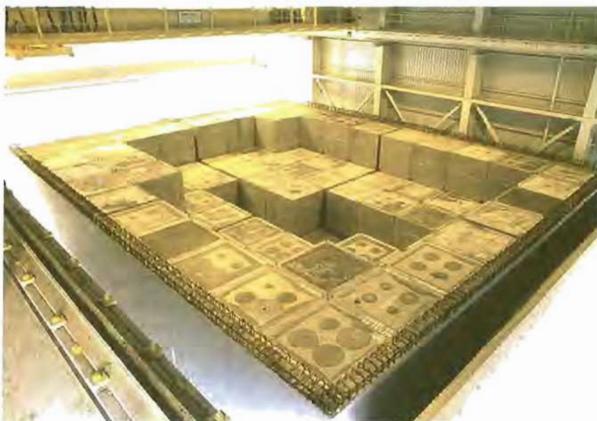
► Figura 2. Interior de una celda de almacenamiento de El Cabril.
