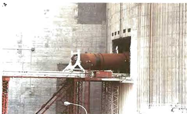
Introducción de un generador de vapor en el edificio de contención de la central nuclear de Almaraz.
