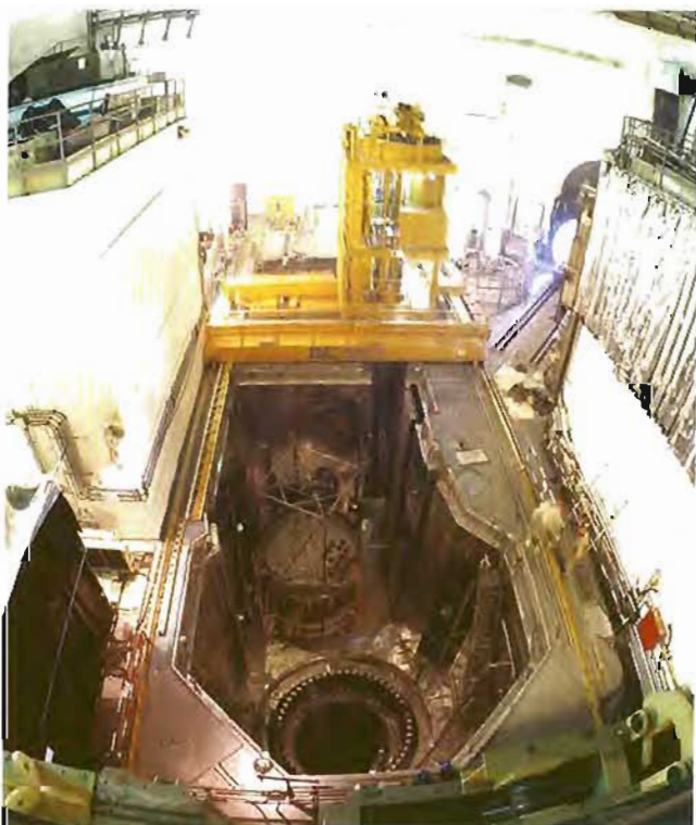
Trabajos en el interior de la piscina de combustible de la central nuclear de Trillo.
