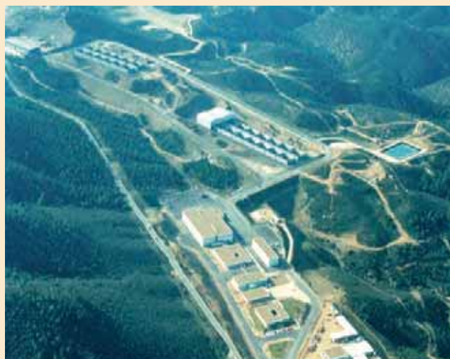
Centro de almacenamiento de residuos de El Cabril.
