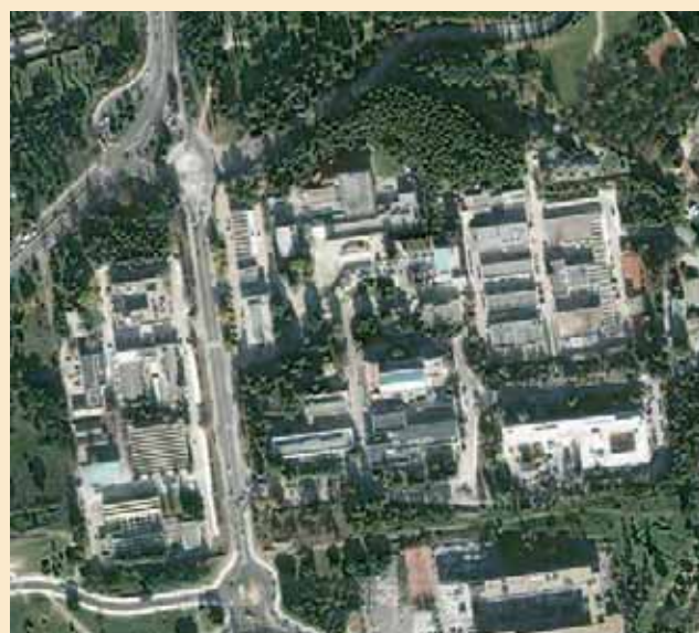
Vista aérea de las Instalaciones del CIEMAT en Madrid.
