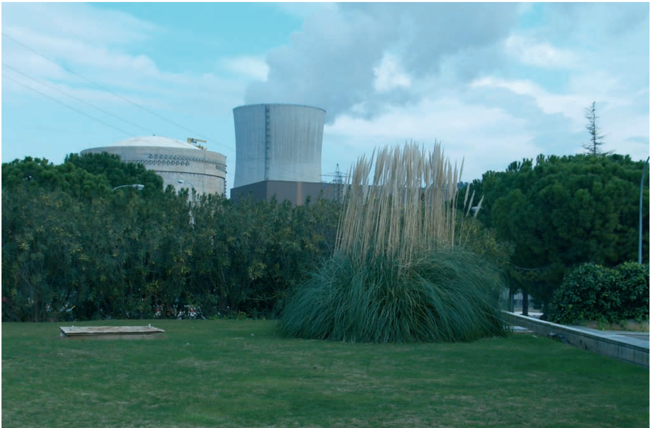
► Panorámica de la central nuclear de Ascó.
