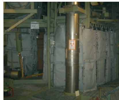
► Figura 1. Blindajes permanentes frente a zonas de trabajo.
