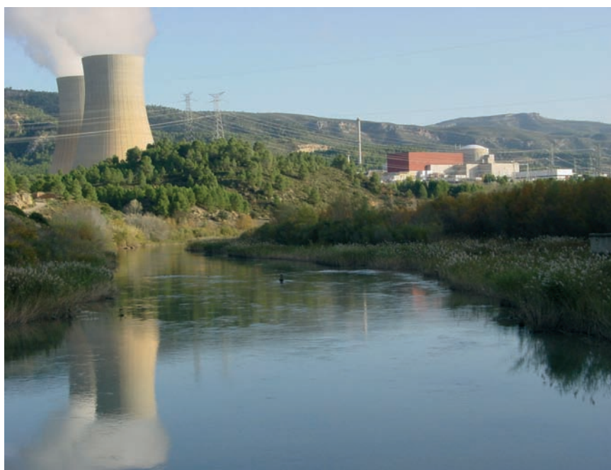
► Vista exterior de la central nuclear de Cofrentes.
