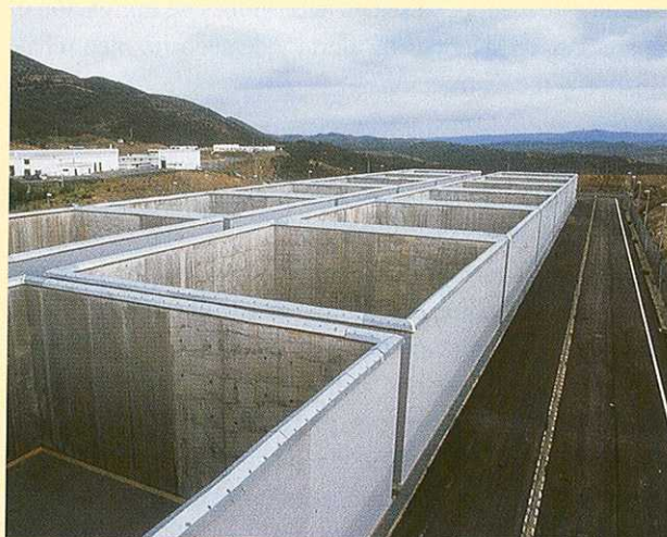
Plataformas de almacenamiento de residuos radiactivos de baja y media actividad en el centro de El Cabril.
