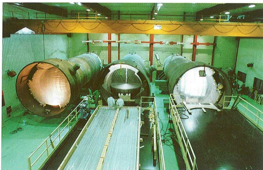
► Figura 1. Trabajos de área limpia en generadores de vapor de las centrales nucleares.
