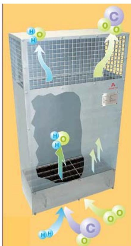
Los PAR constituyen un sistema completamente pasivo. Su única función es la eliminación de gases combustibles liberados a la contención en caso de un accidente severo. Por tanto, su instalación no tiene ningún efecto en la operación normal de la central.
