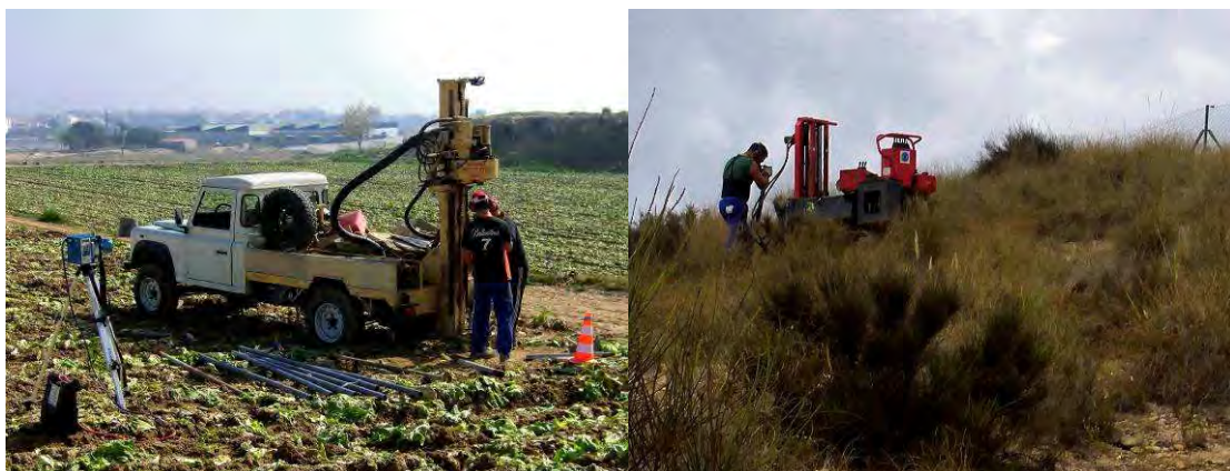
Figura 38: Realización de los sondeos con equipo Todo terreno y penetrómetro.
