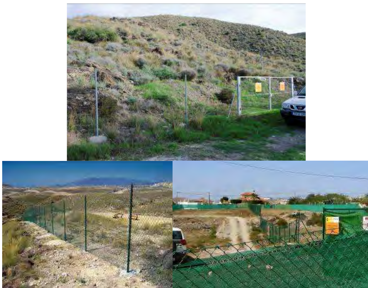
Figura 11: Detalle del Vallado en Zonas 6, 2 y 3
