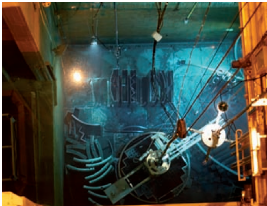
Exterior y del corte de internos del reactor durante el desmantelamiento de la central José Cabrera.
