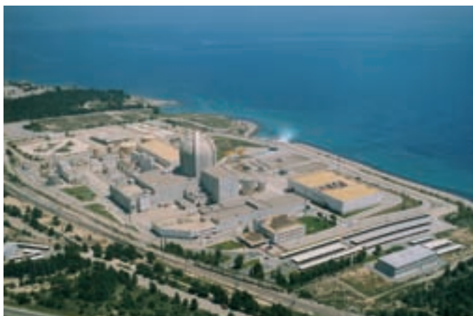
Vista aérea de la central nuclear Vandellós II.
