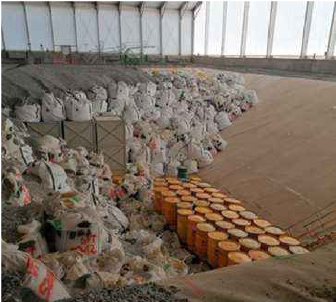
Fotografía 4 Celda 30. Estado actual a 22/06/2023 de llenado sobre el dique de escollera; Detalle
