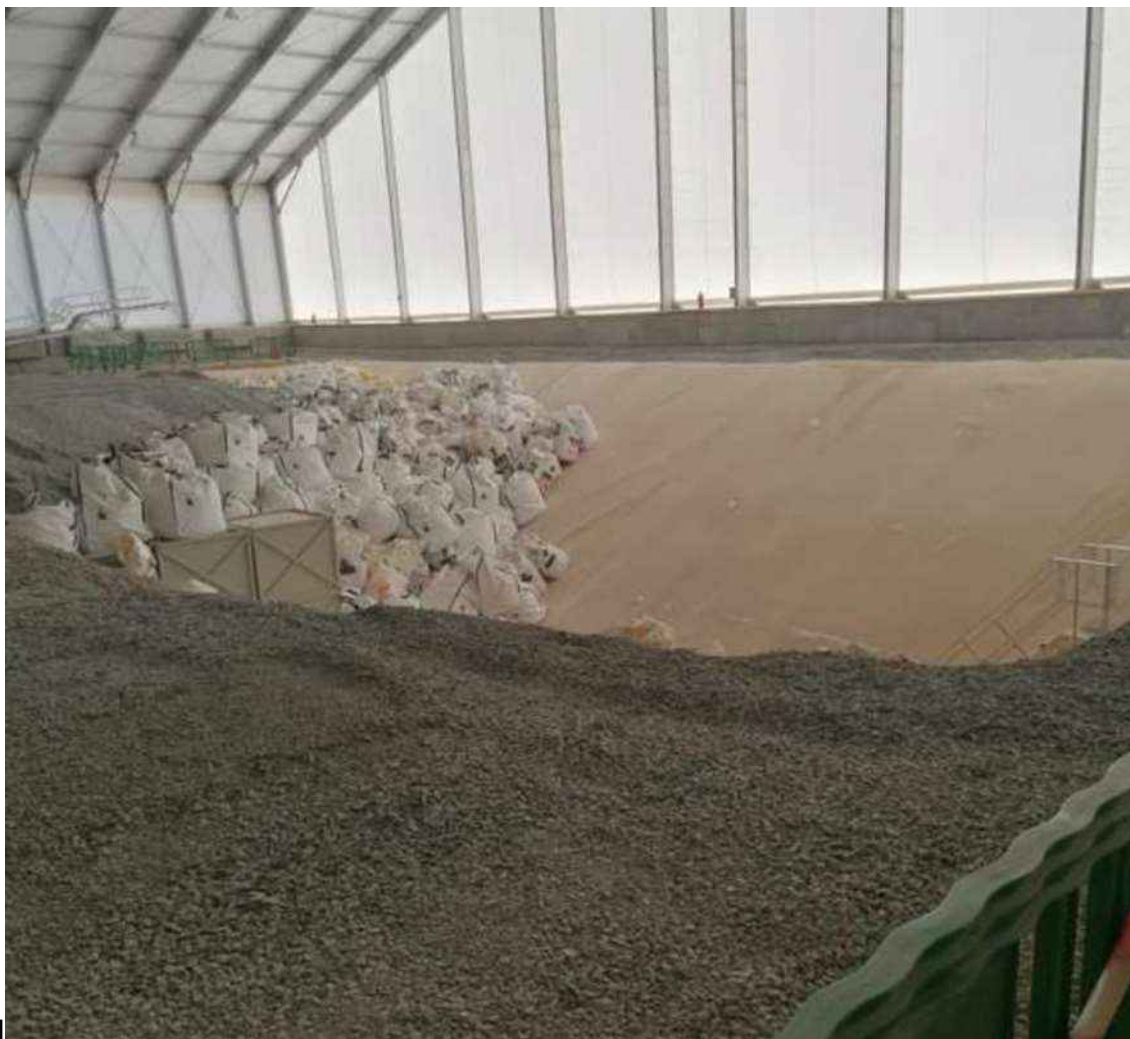
Fotografía 3 Celda 30 incorporacion de residuos convencionales sobre dique de escollera
