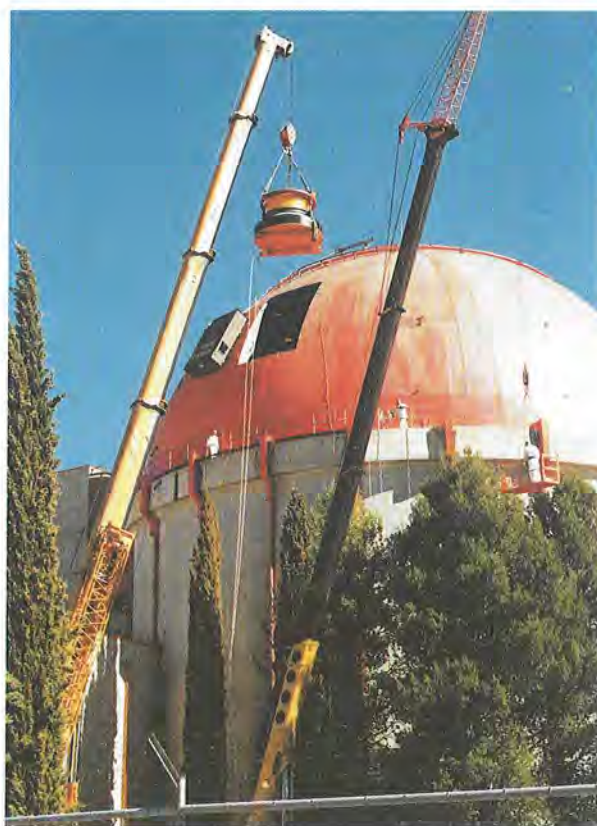
Sustitución de la tapa de la vasija del reactor
