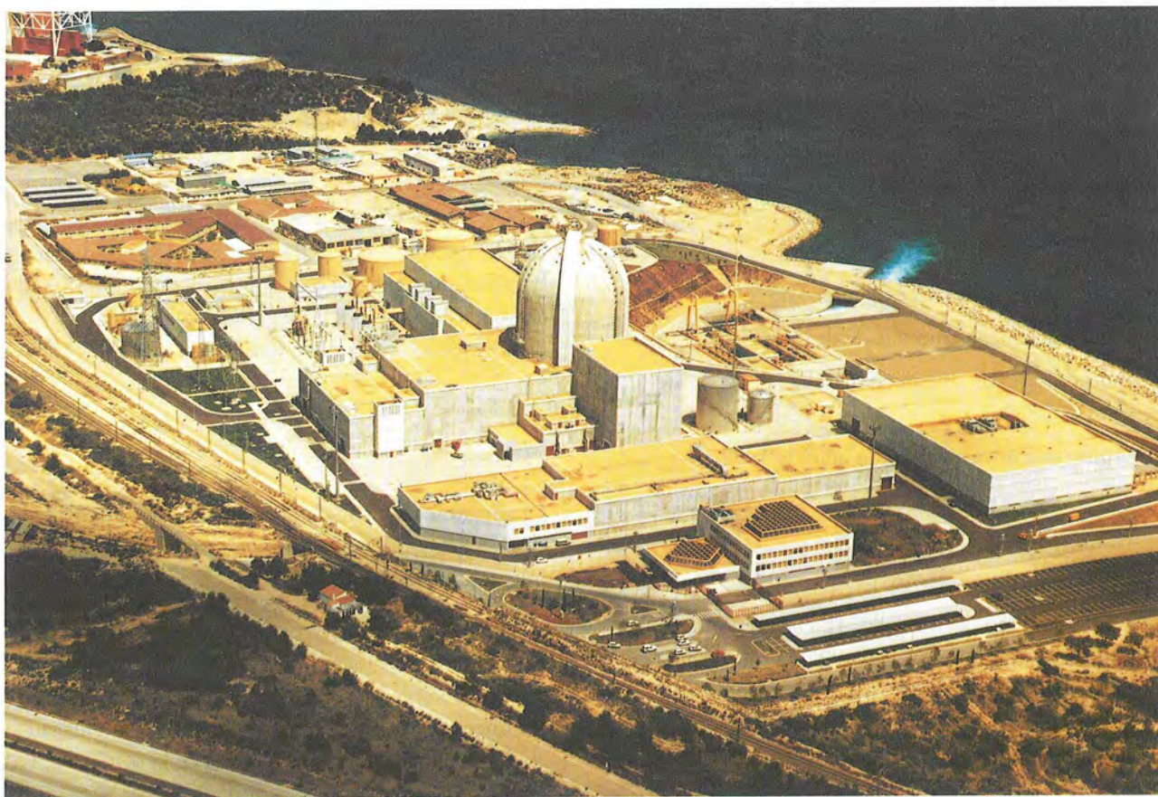
Fotografía aérea de la central nuclear Vandellós II y su entorno
