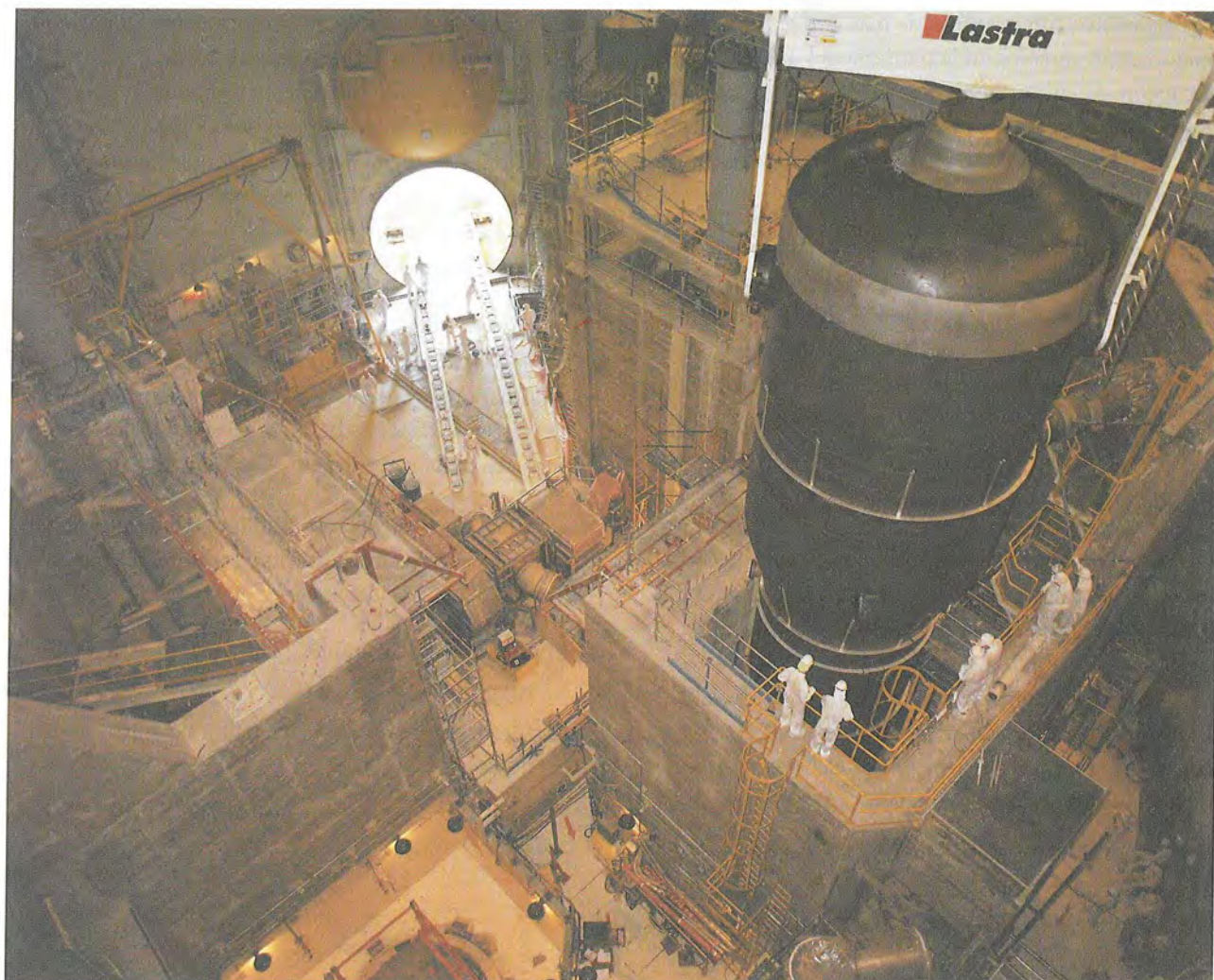
Sustitución de los generadores de vapor en la central nuclear de Ascó
