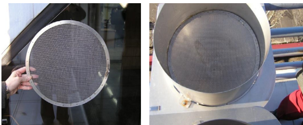
Figuras 3 y 4. Rejilla de protección para el interior del colector de superficie (izquierda) e interior de colector de superficie con rejilla de protección (derecha)
