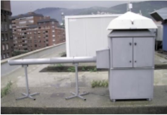
Figura 5. Muestreador de alto flujo
