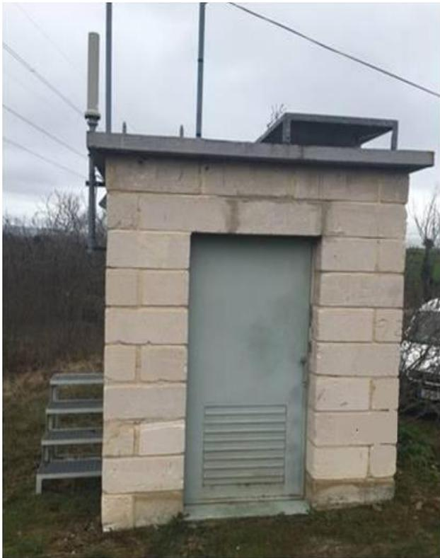
Figura 8. Caseta con equipo de toma de muestras de depósito total
