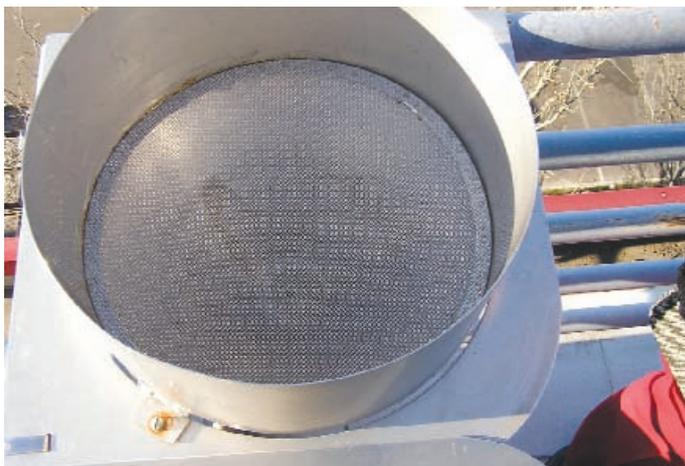
Figura 3. Interior de colector de superficie con rejilla de protección
