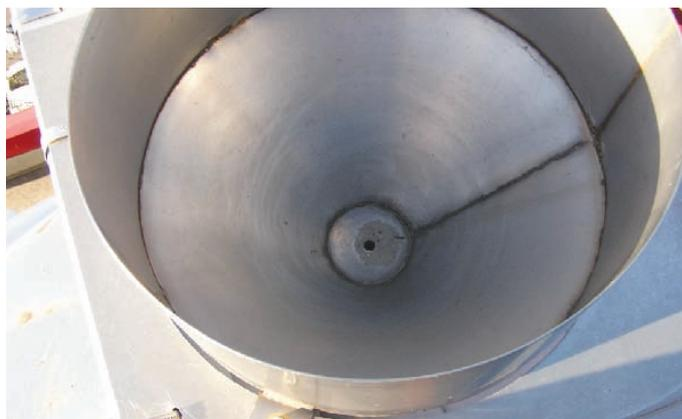
Figura 1. Interior del colector de superficie
