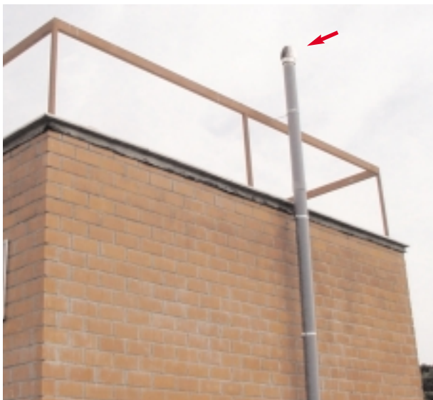
Figura 3.17. Tubo de extracción conectado a la arqueta exterior con un mecanismo de tiro pasivo conectado al extremo de expulsión
