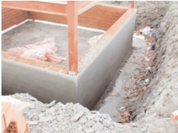
Figura 3.4. Fotografía de la excavación con los muros de sótano
