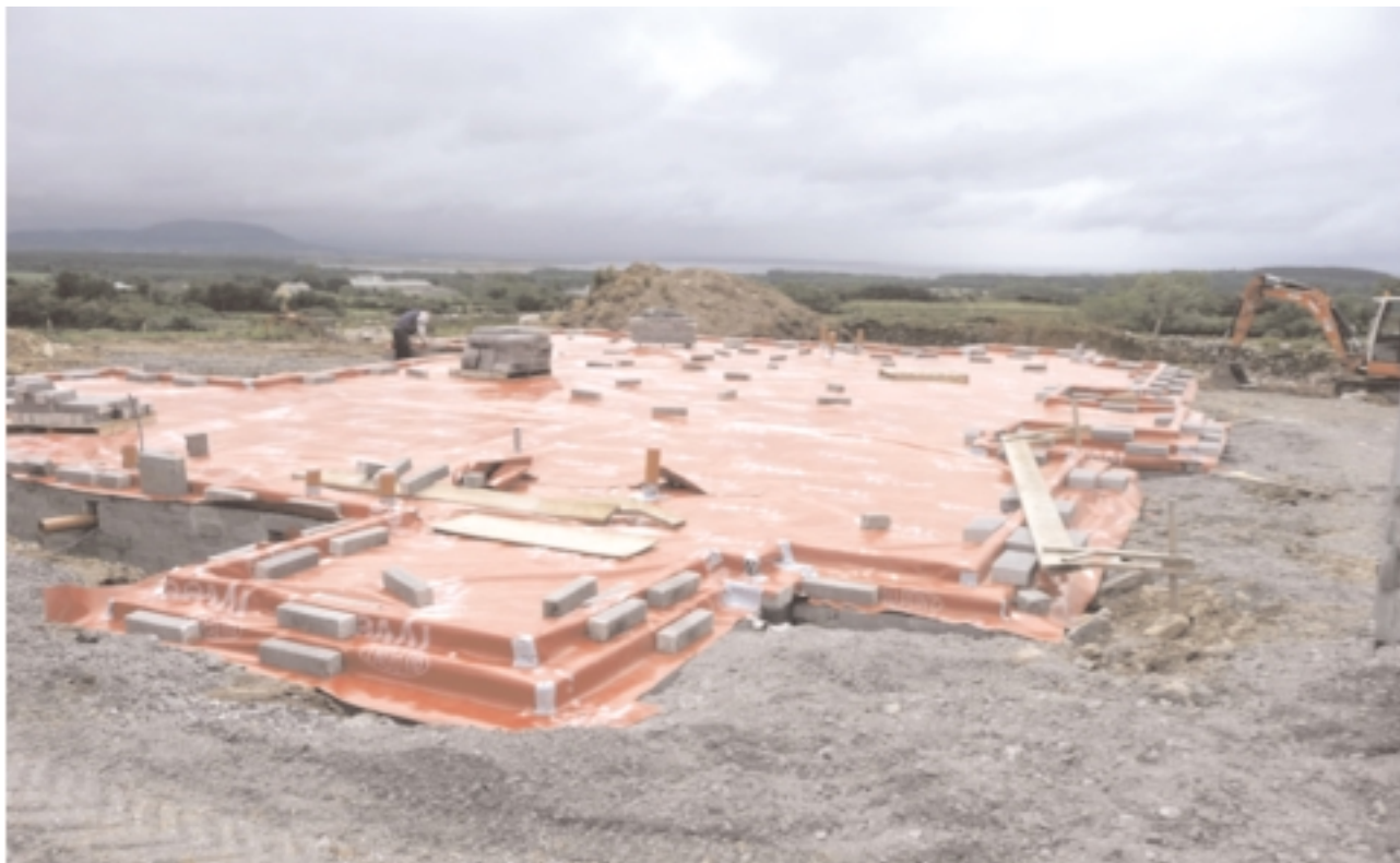
Figura 2.5. Fotografía del proceso de ejecución de un sistema de barrera colocado en el basamento de una edificación en construcción (The Radon Barrier Company Ltd. Irlanda)
