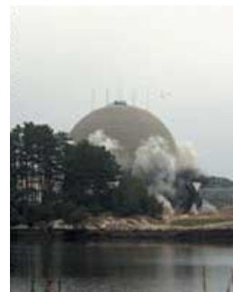
Demolición de la contención de la central nuclear de Maine Yankee.
