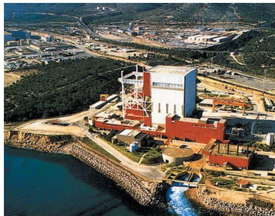
Central nuclear Vandellós I durante la operación.
