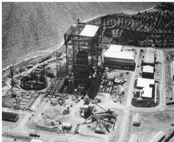
Central nuclear Vandellós I durante la construcción.
