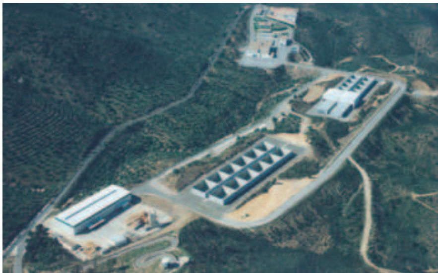
Instalaciones de almacenamiento de residuos de la Empresa Nacional de Residuos Radiactivos (Enresa) en El Cabril (Córdoba).
