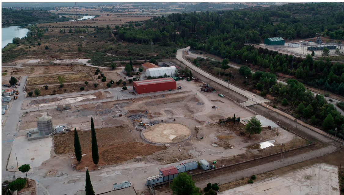
Vista general de la central nuclear José Cabrera en desmantelamiento (Guadalajara).
