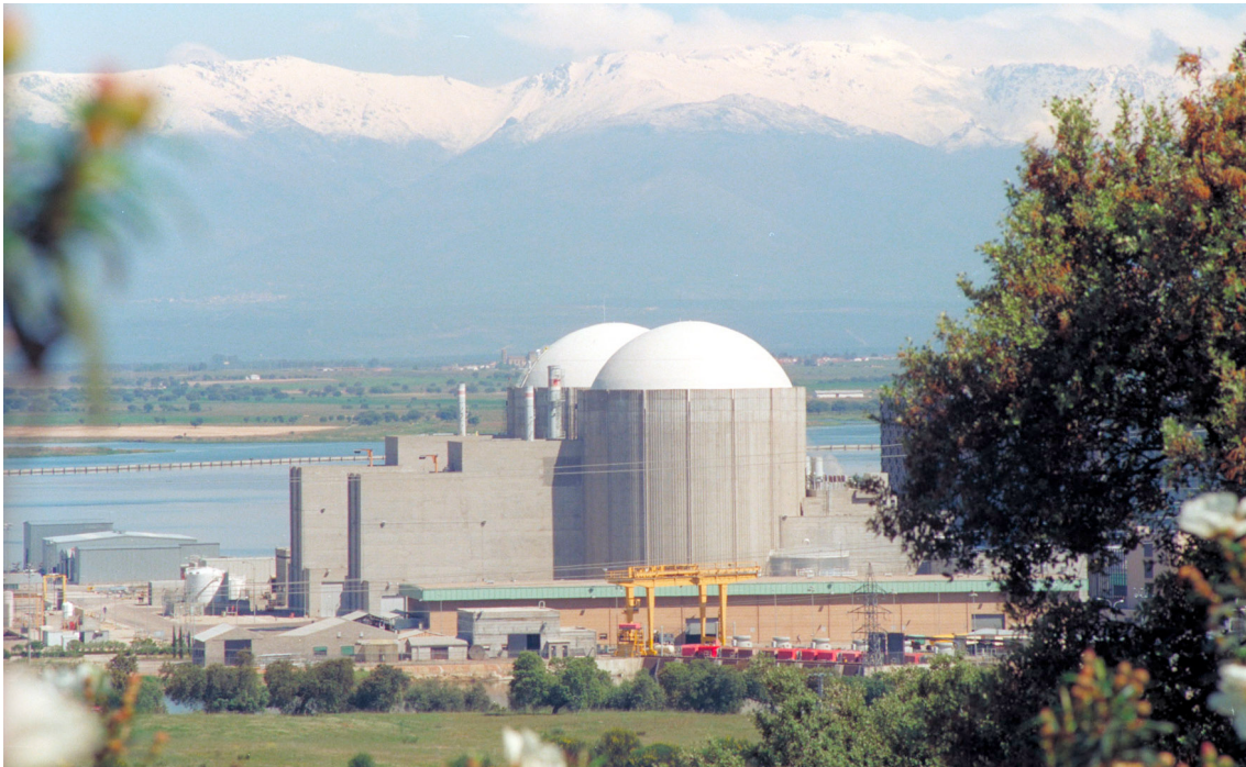
Vista general de la central nuclear Almaraz (Cáceres).
