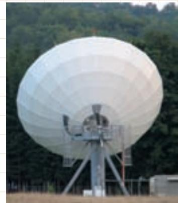
Para determinar la dirección en que se encuentra el objeto se utilizan antenas parabólicas, que tienen la capacidad de recibir sólo impulsos que corresponden a un ángulo específico de dirección.
