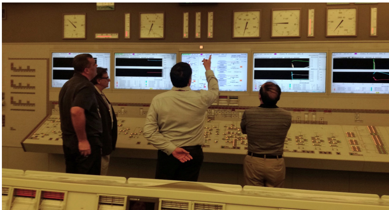
Visita técnica dos peritos do projeto CLOR à sala de controlo da Central Nuclear de Laguna Verde, México.
