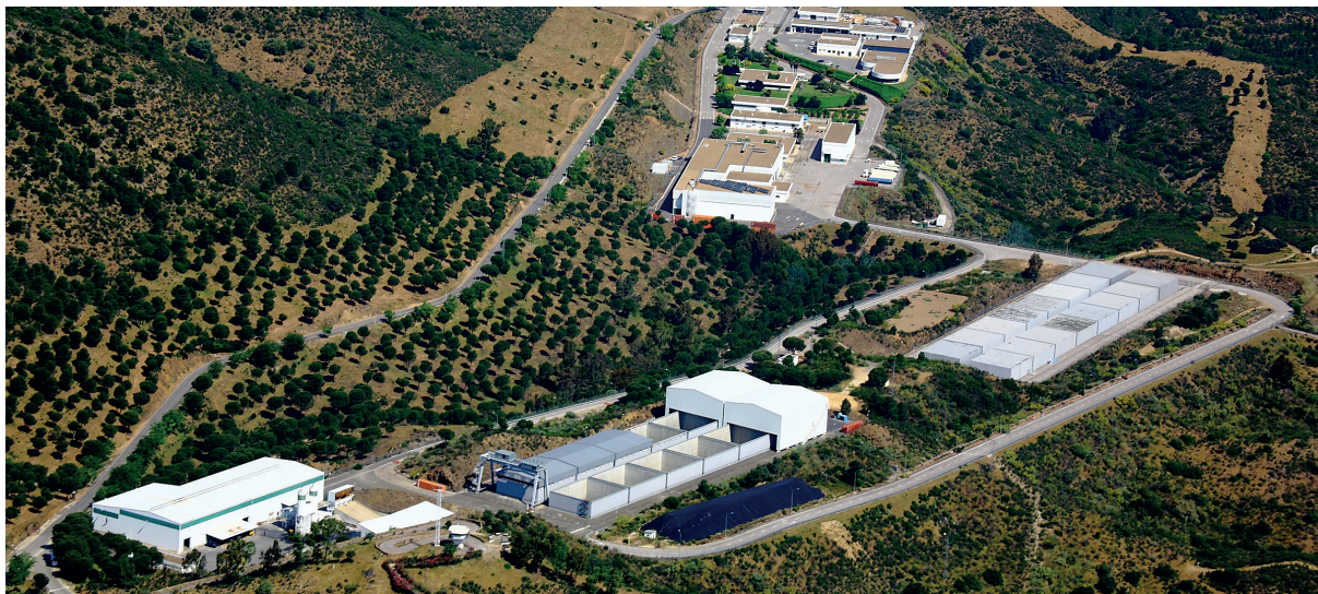
Figura 44. Instalaciones de Enresa en El Cabril.
